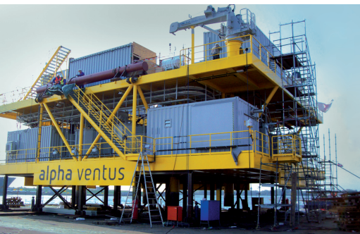
Umschlag, Lagerung und Montage von Großkomponenten wie Umspannwerken
