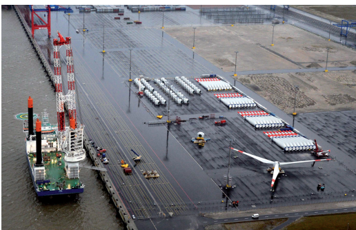
Flächen und Kräne zur Vormontage und Verladung von Offshore-Komponenten
